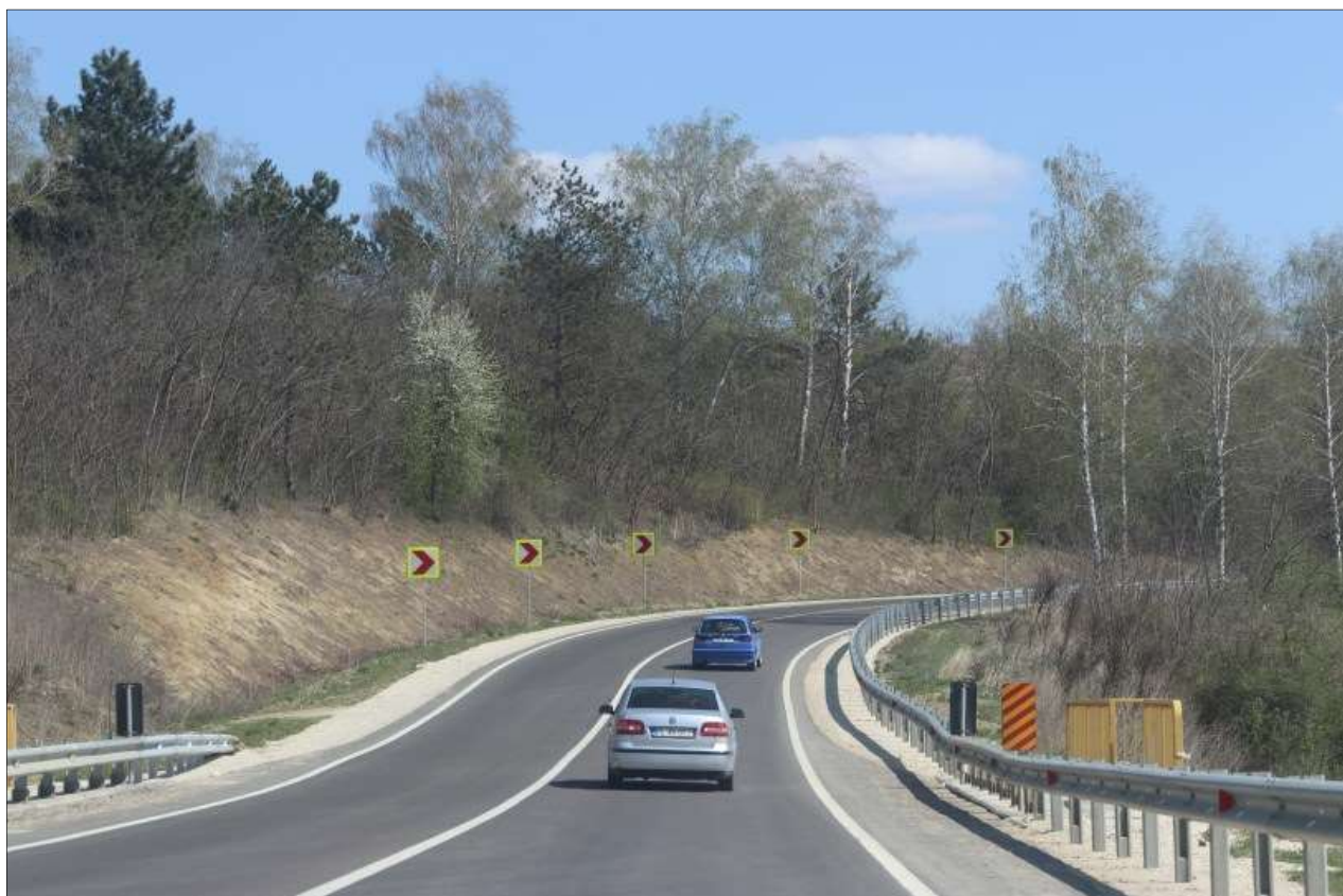
Anexa 36. Drumul republican R1, segmentul Călărași – Bucovăț [283]
