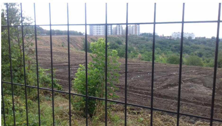
Fig. 4: Partea superioară a hârtopului dintre străzile Grenoble și Costiujeni, în mare parte acoperită cu rocă argilasă, nivelată și tasată și pregătită ca teren pentru construcții.
